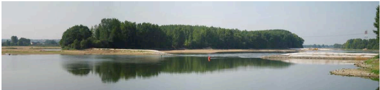
Vue de l'épi amont
